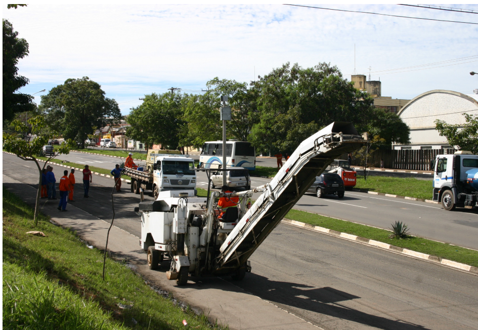
Trabalho de recapeamento continua na avenida Júlio Vasconcelos
