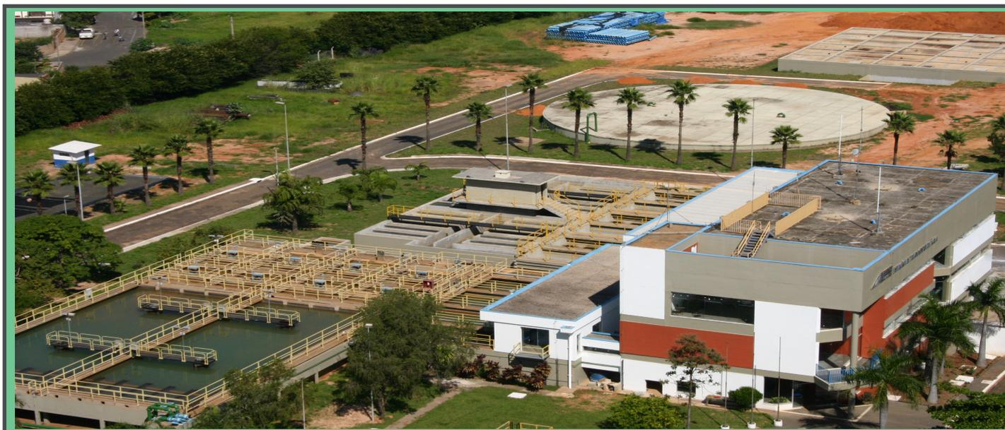
Estação de Tratamento de Água do Parque Itália conta com novos módulos de tratamento e reservatório de 5 milhões de litros
