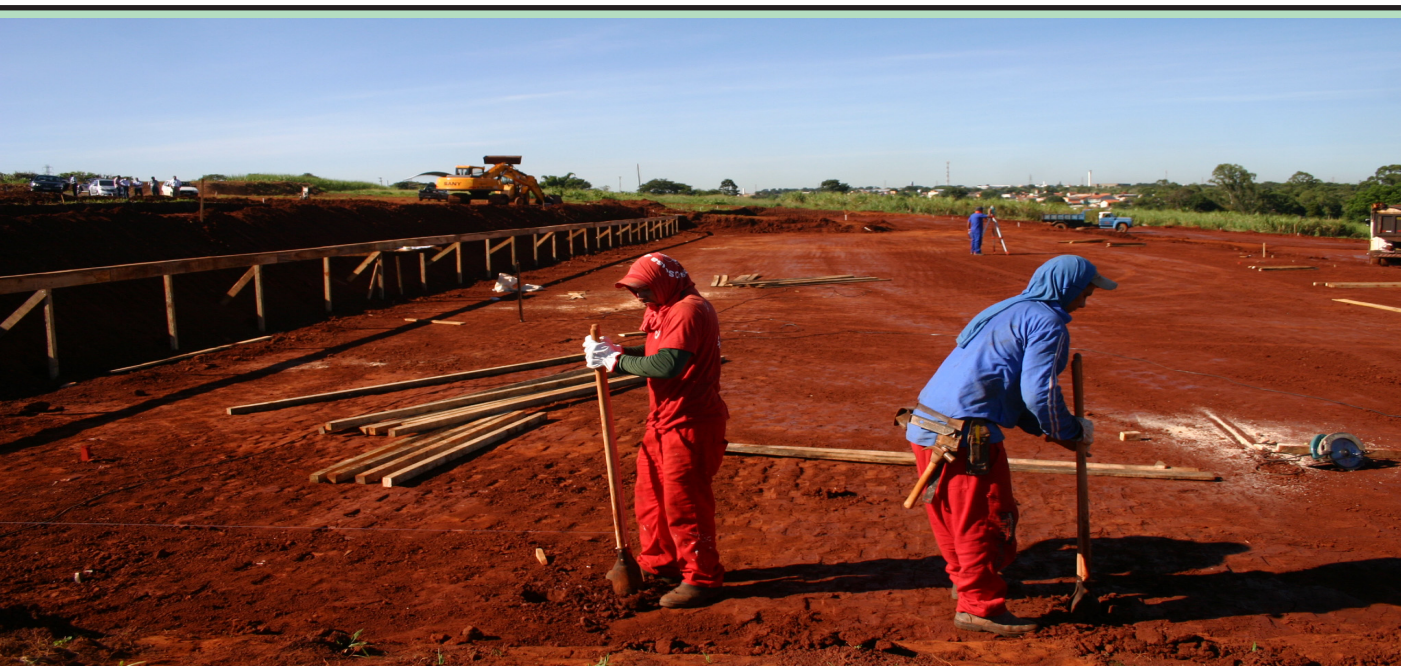
Empreendimentos habitacionais estão se tornando realidade na Região do Matão; no total 2.956 casas populares
