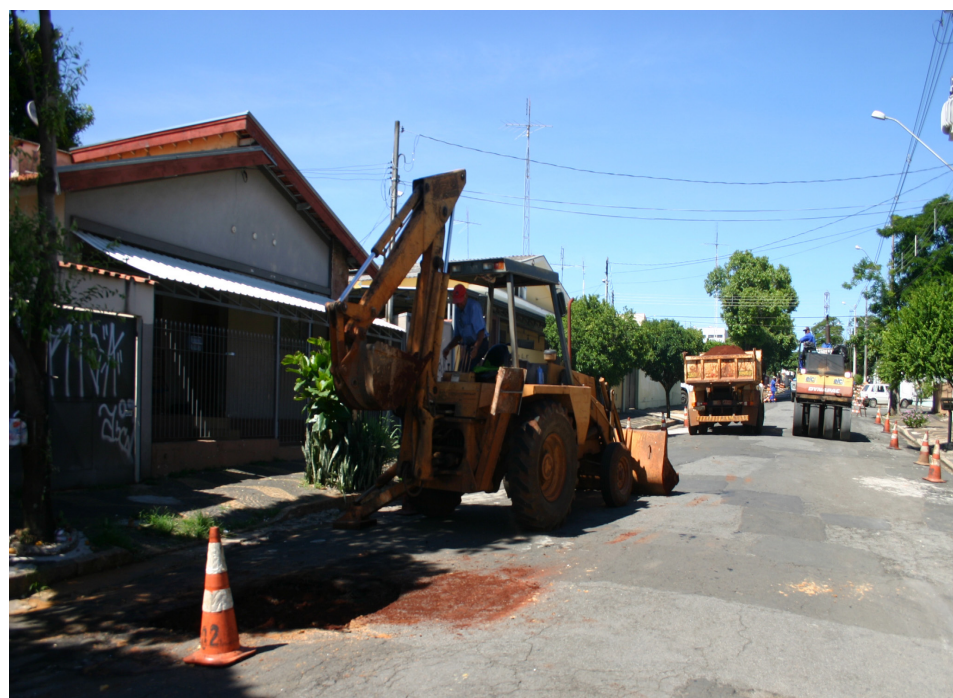
Além do recapeamento, rua Máximo Biondo recebeu manutenção de rede de água
