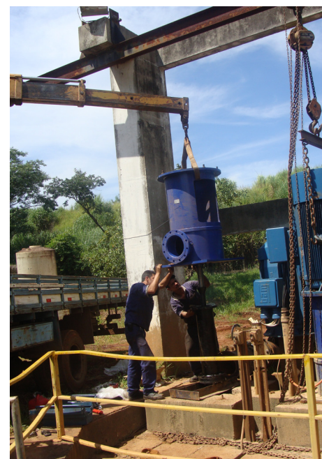
Novo equipamento foi instalado na captação
