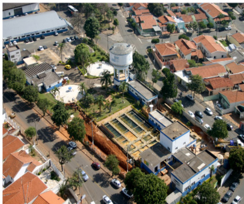
Estação de Tratamento da Vila Miranda será atingida pela falta de energia
