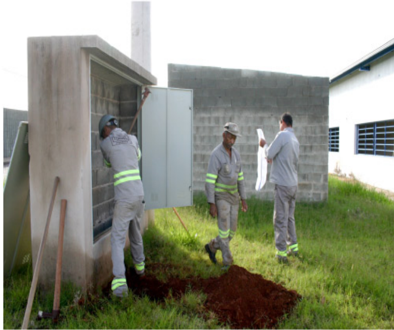
Foi retomada ontem as obras do Pronto Socorro do Jardim Macarenko
