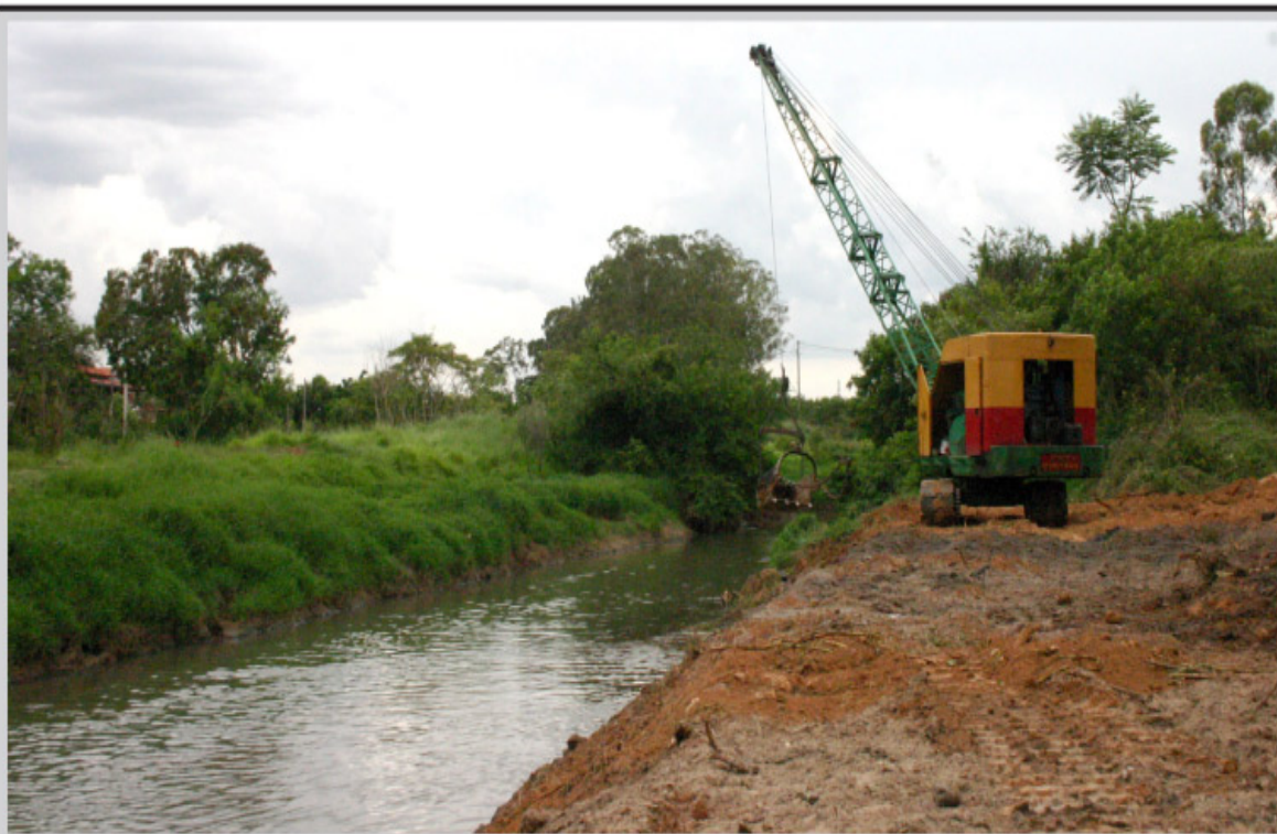
Trabalho de limpeza e aprofundamento da calha do ribeirão vem sendo realizado por meio da dragagem do Quilombo
