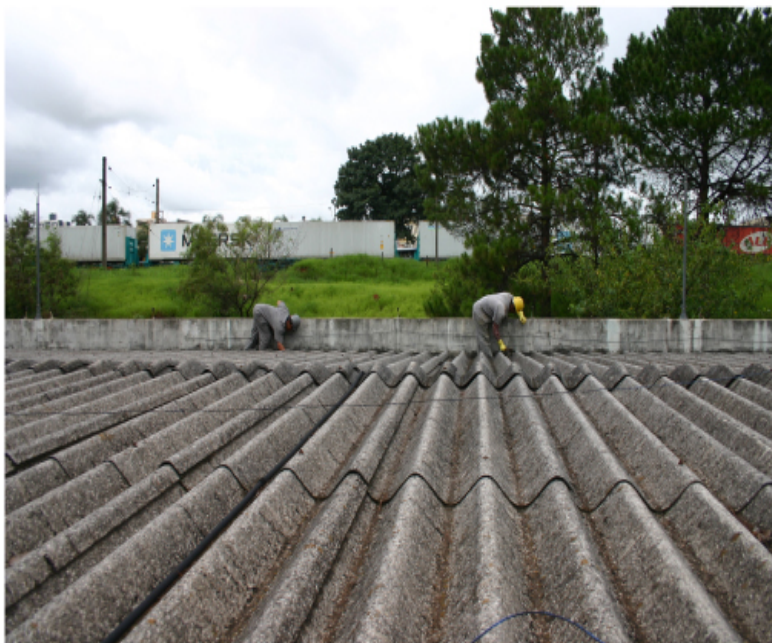
Reforma no telhado do Ambulatório de Especialidades já foi iniciada
