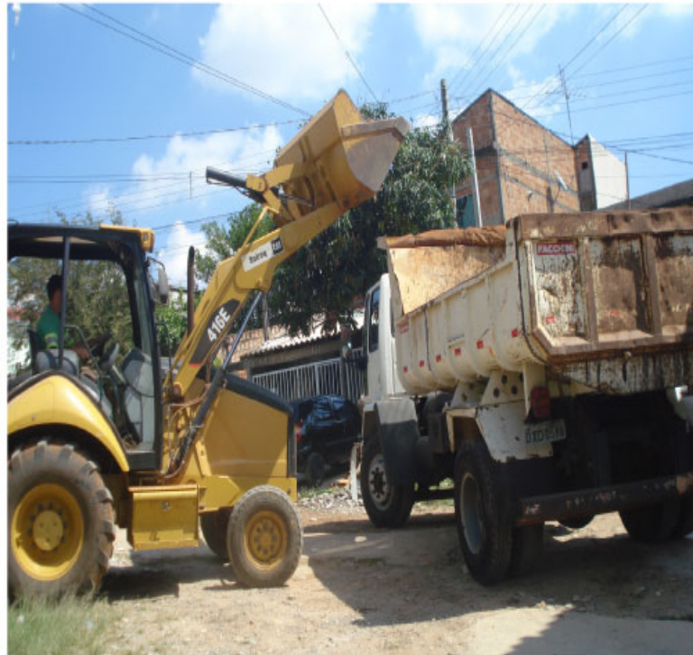
Máquinas realizam limpeza após derrubada de casa em área de proteção ambiental
