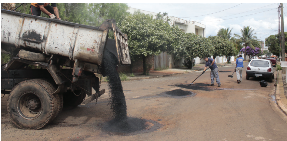
Avenida Sete de Setembro: Operação Tapa-Buraco avançará no Jardim Macarenko e Região
