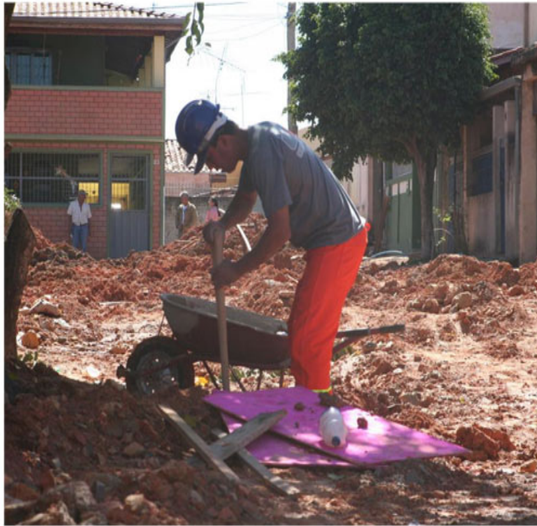
Obras de infraestrutura começaram a ser executadas no Jd. Conceição 2
