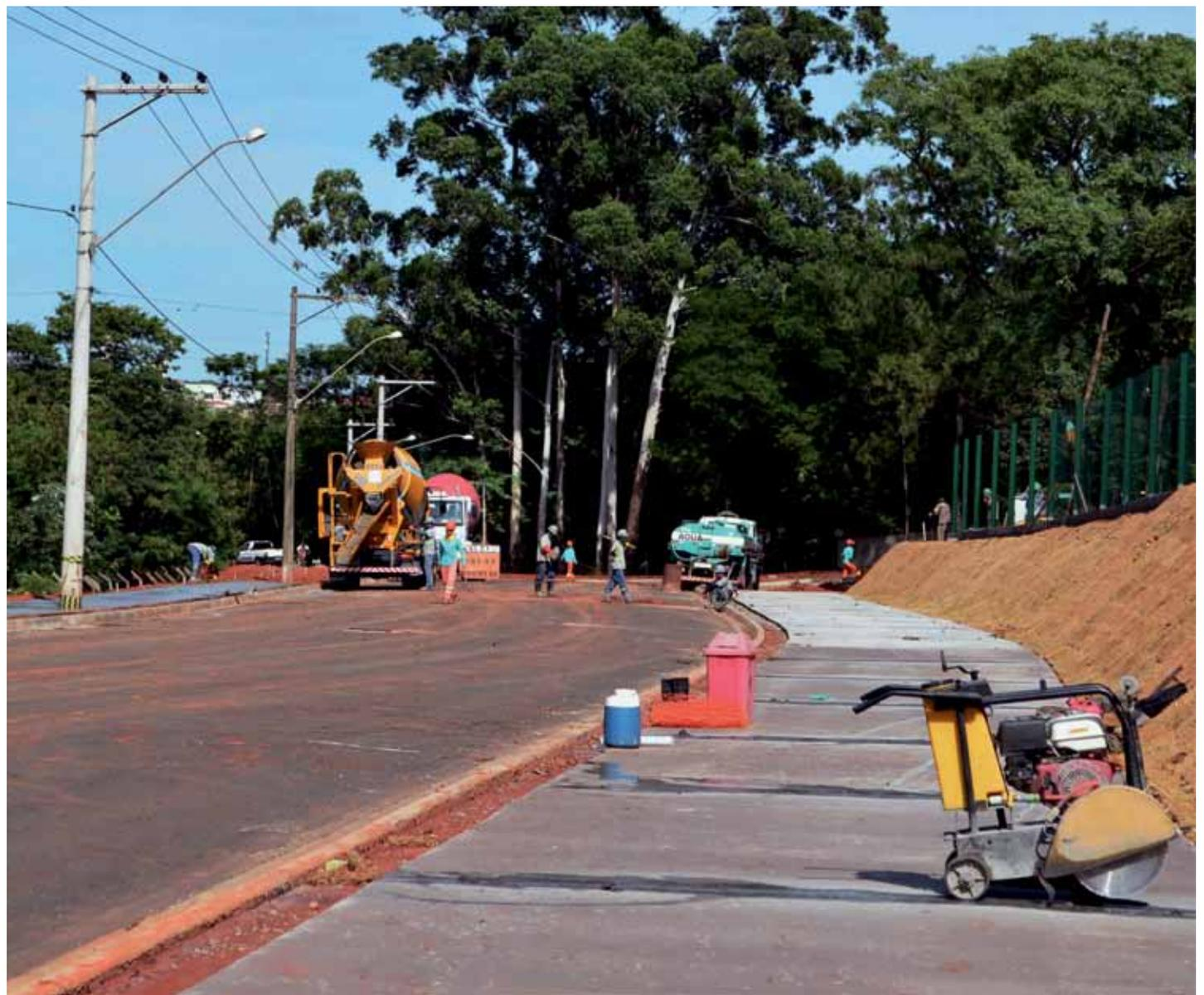
As obras contemplam a pavimentação de todos os 855 metros de extensão da via, totalizando 9.900 metros quadrados de asfalto novo, 1.700 metros quadrados de ciclovia, 3.400 metros quadrados de calçadas e 825 metros de novas galerias de águas pluviais.
