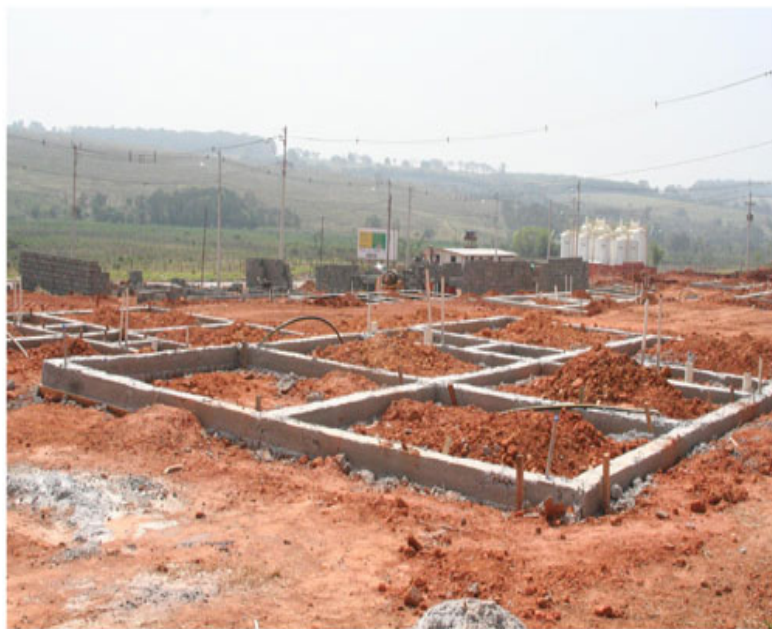
Canteiro de Obras no Portal Bordon II se encontra na fase de fundação
