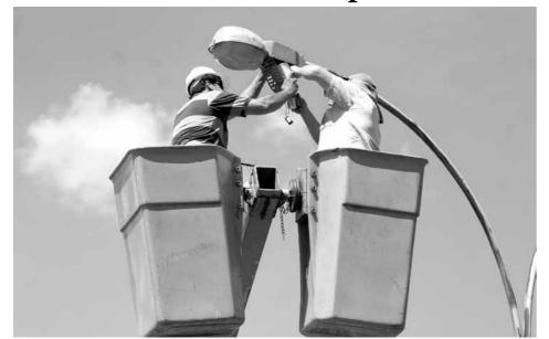
A Prefeitura de Sumaré, dando sequência ao Programa de Modernização da Iluminação Pública das praças da cidade, realizou a substituição de lâmpadas de vapor de sódio por vapor metálico em mais três locais. A nova iluminação garante uma maior sensação de segurança a quem vive, trabalha ou transita pelos locais beneficiados pela medida, auxiliando também a evitar acidentes de trânsito.
