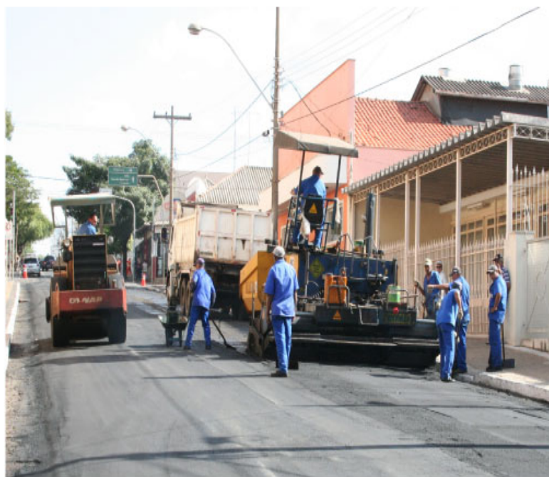
Trabalho de recuperação da malha asfáltica beneficiará 18 ruas e avenidas
